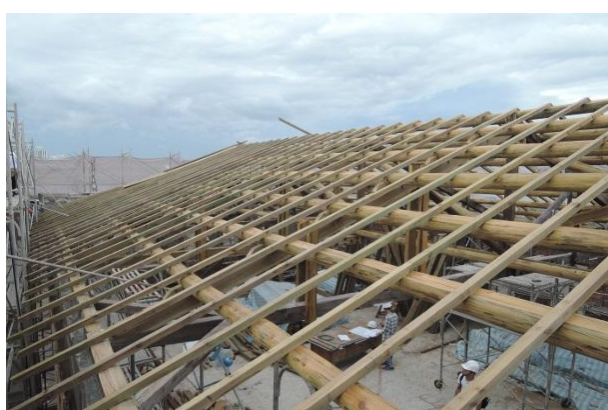
屋頂桁木垂木
