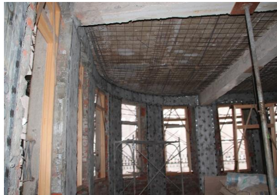
樓板及牆面補強
